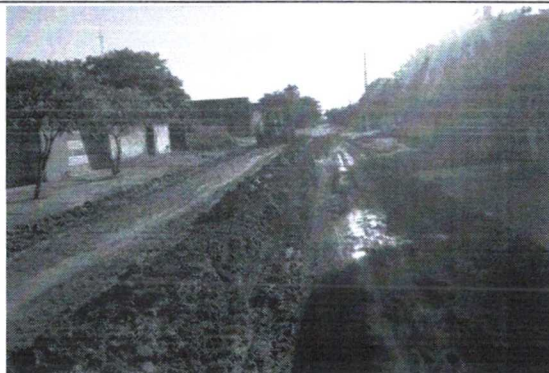
FOTO 01 - PREPARO SUBLEITO - RUA TREZE DE MAIO
