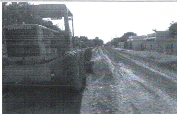
FOTO 05 - EXECUÇÃO E COMPACTAÇÃO DE BASE - RUA TREZE DE MAIO
