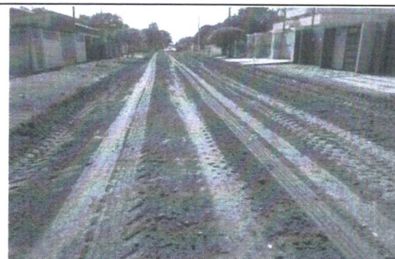
FOTO 04 - EXECUÇÃO E COMPACTAÇÃO DE BASE - RUA TREZE DE MAIO
