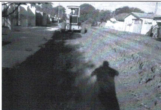
FOTO 03 - PREPARO SUBLEITO - RUA TREZE DE MAIO
